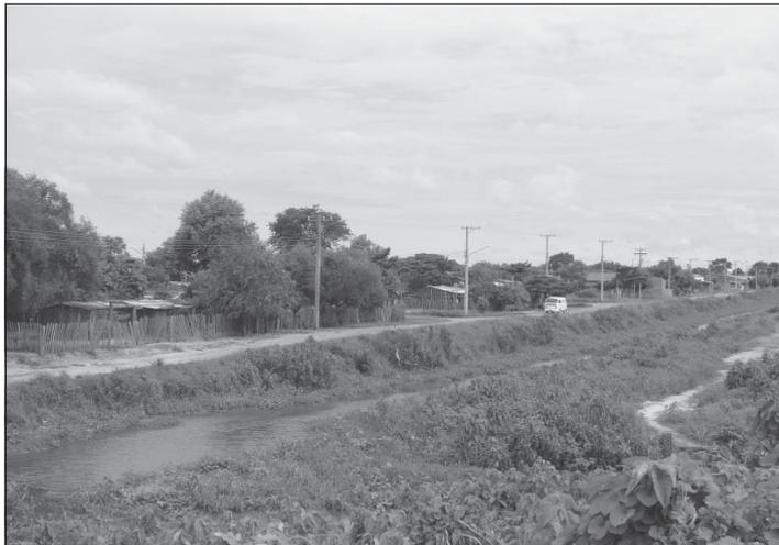
Acima, o dique construído em Porto Murtinho após uma cheia que alagou completamente a cidade em 1982. Uma bomba joga a água para fora do perímetro urbano, caso o nível das águas ultrapasse a barreira.
